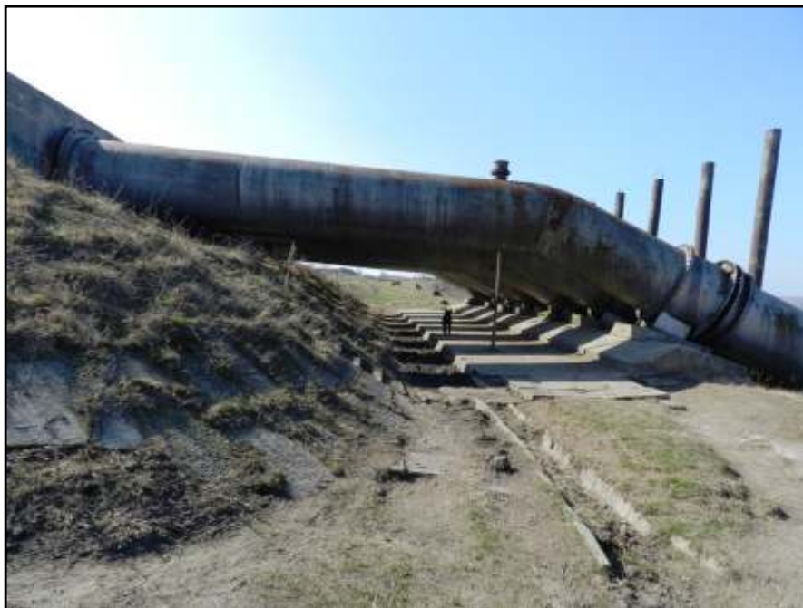
Fig. nr.6. Conducte de aductiune aferente SPAP
