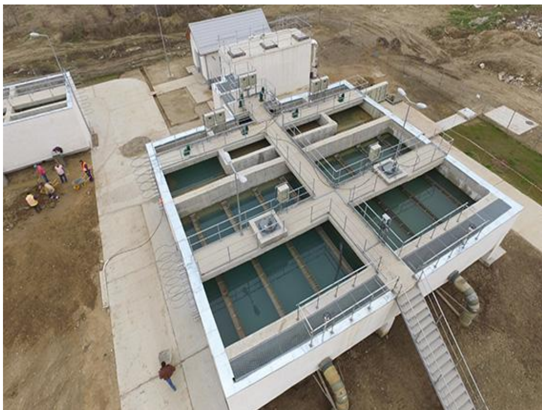
Figura 97 Stație de tratare apă Calafat
